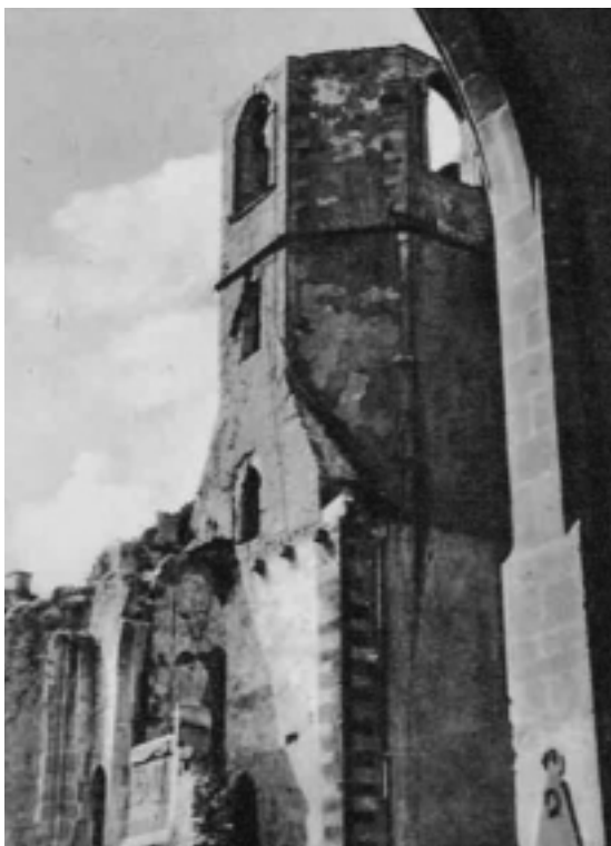
Der zerstörte Turm der Liebfrauenkirche
