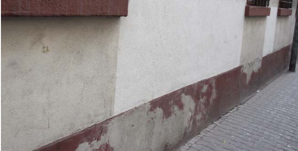
Im Sockel am Schärfengäßchen und Holzgraben sind Feuchtigkeitsschäden durch Innenschwitzen nur notdürftig bedeckt worden.
