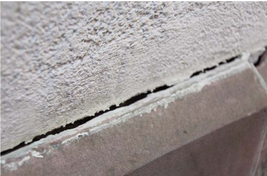
Platten lösen sich von der Wand im Durchgang vom Hof zum Schärfengäßchen
